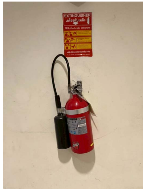
รูปที่ 1.10-1 ตัวอย่างการติดตั้งถังดับเพลิงเคมีแบบมือถือที่ติดตั้งในอาคารเดิม
