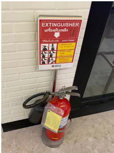
รูปที่ 1.10-1 ตัวอย่างการติดตั้งถังดับเพลิงเคมีแบบมือถือที่ติดตั้งในอาคารเดิม
